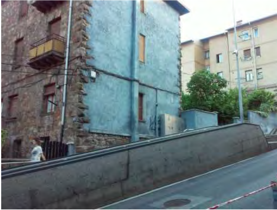
Vista de la casa de piedra desde la calle Doctores Landa donde se puede apreciar la rampa mecánica.
