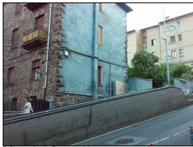
C/ Doctores Landa. Rampa mecánica.
