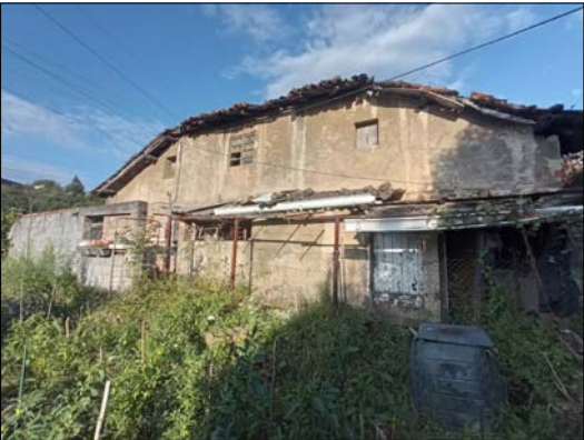
VISTA EDIFICACIÓN DESDE PARCELA
