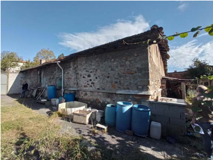
VISTA DE EDIFICACIÓN ACTUAL DE SDE EL SUR
