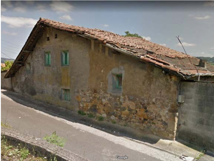
VISTA DE EDIFICACIÓN ACTUAL DE SDE VIAL EN LINDERO OESTE
