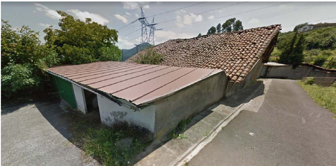
VISTA DE CUBIERTA
