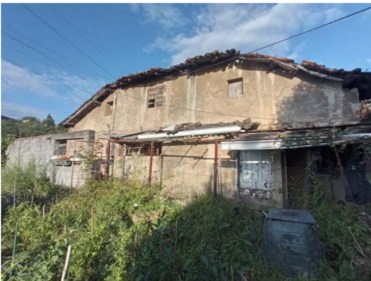
VISTA DE EDIFICACIÓN ACTUAL DE SDE EL ESTE HACIA PARCELA
