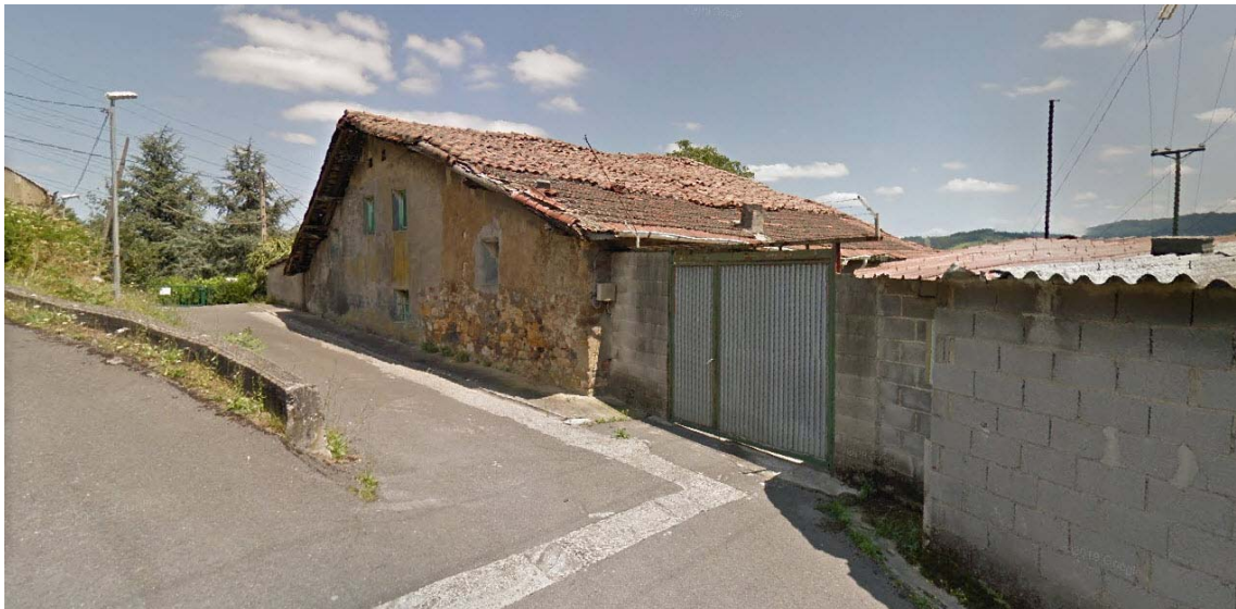
VISTA DE PARCELA Y EDIFICACIÓN ACTUAL DESDE EL VIAL EN LINDERO OESTE)
