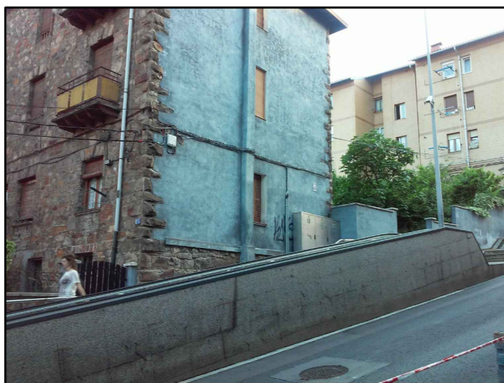
C/ Doctores Landa. Rampa mecánica.
