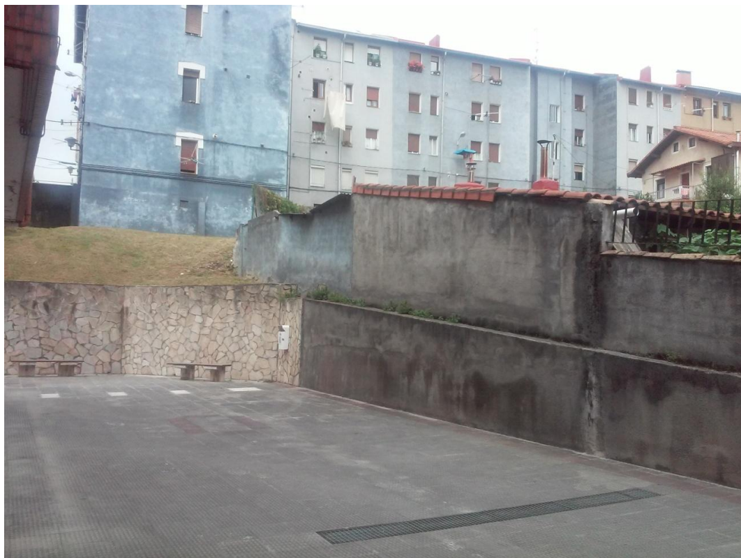
Calle Altube, límite de la actuación por el Sur, futuro acceso a las plantas de garaje. Público
