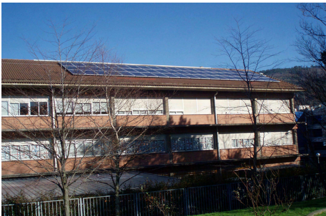
Argazkia: Sareari lotutako eguzki instalazio fotovoltaikoa Calderon Herri Ikastetxean
