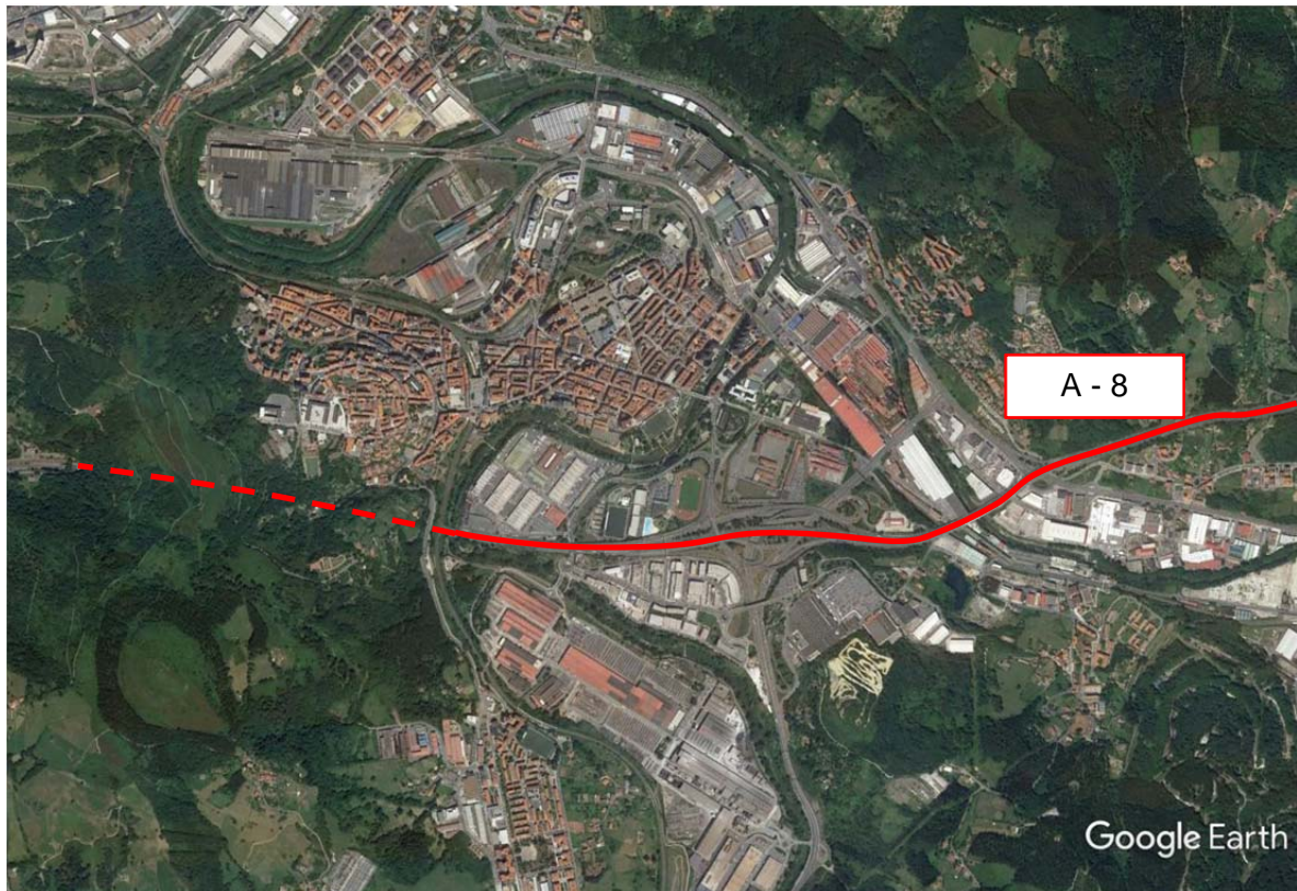
Figura 4: trazado de la carretera A-8 (imagen obtenida en Google Earth).
