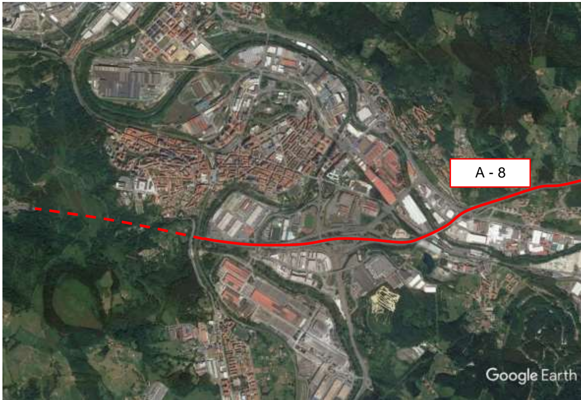
Figura 90: Trazado de la carretera A-8 (imagen obtenida en Google Earth).
