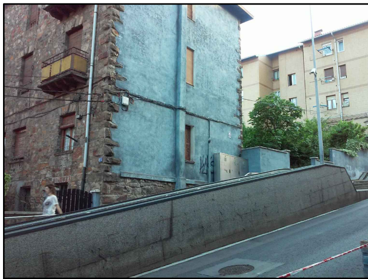
C/ Doctores Landa. Rampa mecánica.
