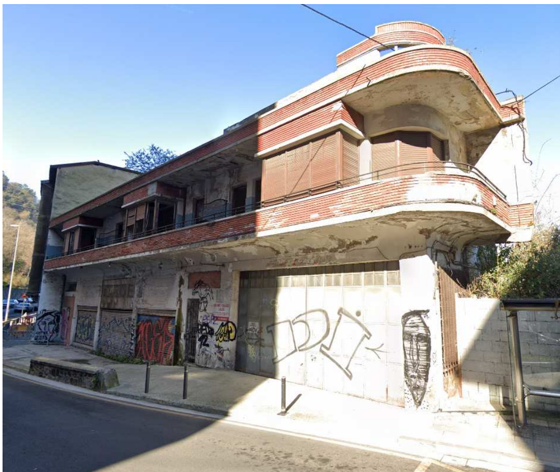
Edificio existente en Kareaga Goikoa 9 y 11.
