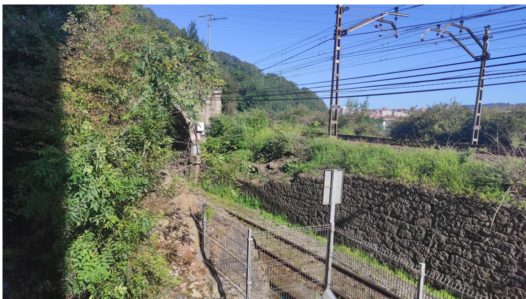
Límite norte de la AI 02 con túnel ferroviario.
