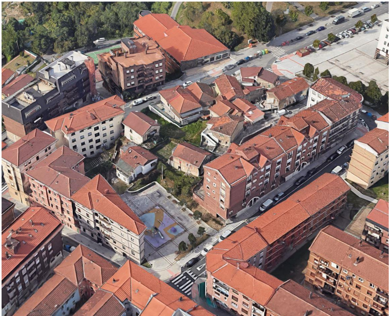
Vista aérea de la manzana (NE)
