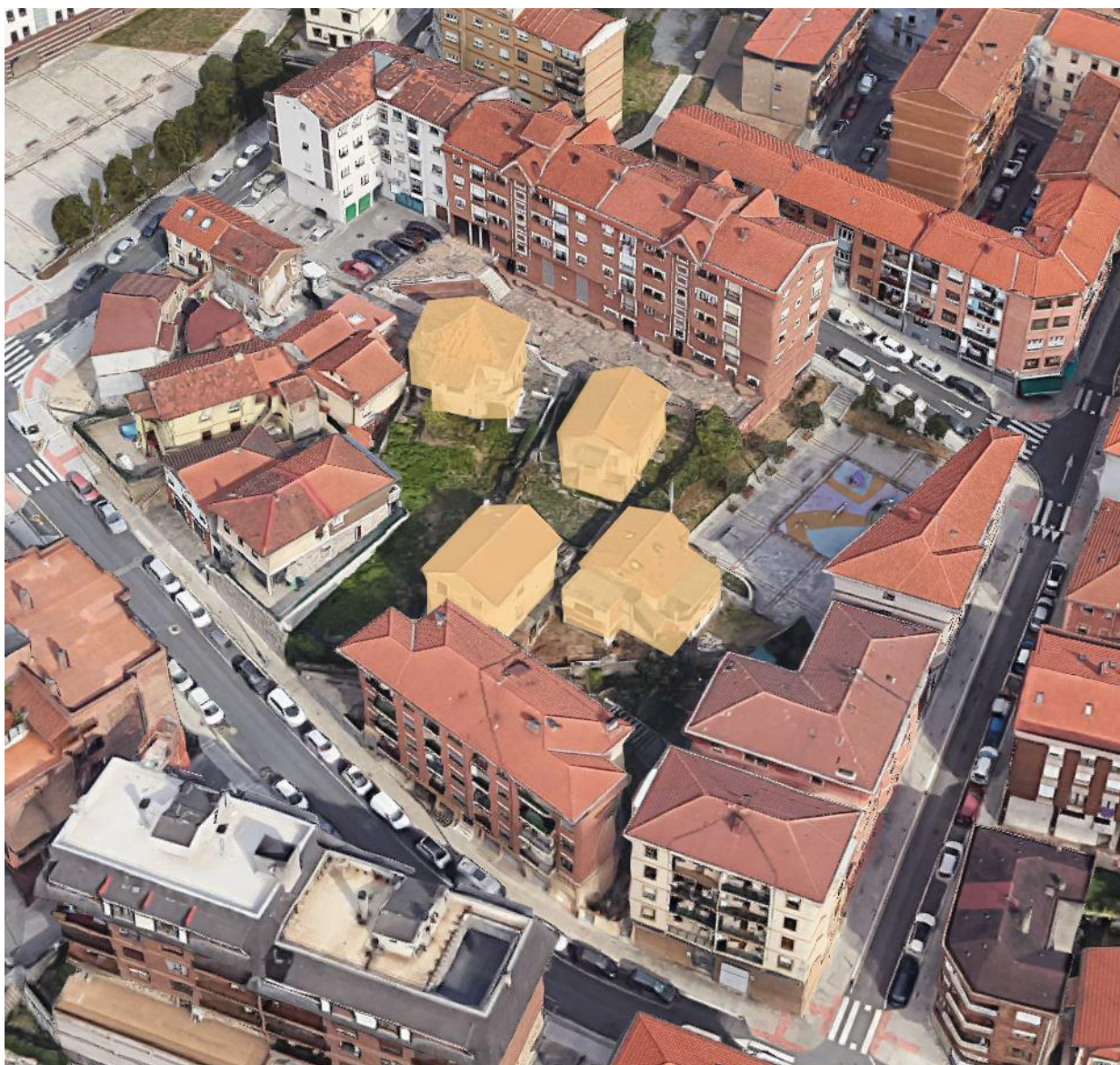
Vista aérea de la manzana (SW). Edificios fuera de ordenación.
