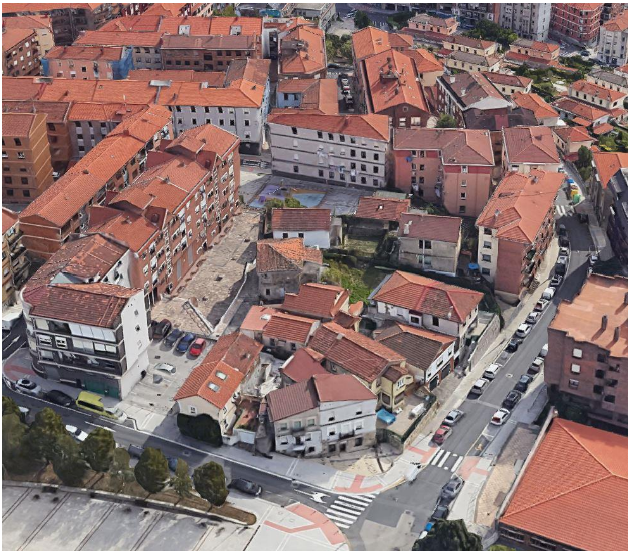
Vista aérea de la manzana (SW)
