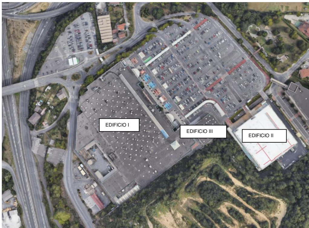
Estado Actual de la edificación
